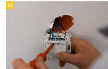
23 Der Anschluss des Heizkabels, des Bodenfühlers und des Thermostats erfolgt durch eine Elektrofachkraft. Für das Thermostat IndorTec® THERM-E bestehen eigenständige Montage- und Bedienungs-/Programmierungshinweise, diese sind den Verpackungen beigefügt bzw. stehen als Download auf den Produktseiten im Internet zur Verfügung.
