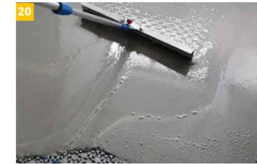
20 Anschließend wird die IndorTec® THERM-E Trägermatte mit einer selbstverlaufenden Bodenspachtelmasse wie z.B. WAKOL Z 610 Ausgleichsmasse, staubarm mit einer Mindestüberdeckung von 5 mm verspachtelt.
