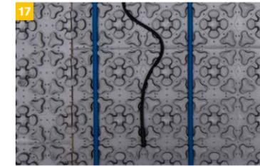
17 Einlegen des Bodenfühlers zwischen zwei Warmleitern des Heizkabels.
