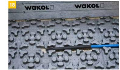
18 Für das Ende des Warmleiters schneidet man der Länge nach eine Kerbe in die Matte. **Wichtig: Ein Kürzen des Warmleiters ist unzulässig und führt zur Beschädigung des Systems!**
