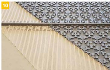
10 An Bauwerkstrenn- und Bewegungsfugen sind die Trägermatten zu trennen. Die Ausbildung der Fugen erfolgt nach Vorgaben der Regelwerke und Herstellerverlegevorschriften der entsprechenden fließfähigen Bodenspachtelmasse und des Bodenbelages.
