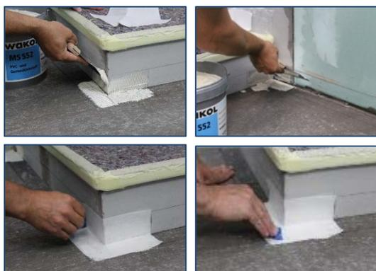
**\*Schritt 2 //** WAKOL MS 552 PVC- und Gummiklebstoff mit Zahnung TKB B1 im Bereich der Innen- und Außenecken aufziehen. WAKOL AS 153 Abdichtungsecke, innen und WAKOL AS 154 Abdichtungsecke, außen einlegen und andrücken.
