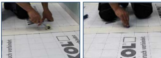
**\*Schritt 8 //** WAKOL MS 552 PVC- und Gummiklebstoff im Bereich der Installationsöffnungen an der Wand auftragen und mindestens 20 Minuten ablüften lassen.
