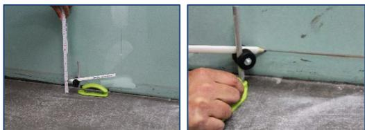
**\*Schritt 1 //** Markierung der Bereiche des Wandhochzuges für den Klebstoffauftrag an Wand und Boden in 6 cm Höhe und Breite.
