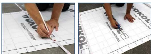
**\*Schritt 4 //** Anzeichnen und Zuschneiden der WAKOL AS 151 Abdichtungsbahn für den Boden- und Wandbereich.
