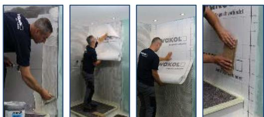
**\*Schritt 5 //** WAKOL MS 552 PVC- und Gummiklebstoff mit Zahnung TKB B1 auf die Wand auftragen und ca. 20 Minuten ablüften lassen, um die Anfangshaftung zu erhöhen.
