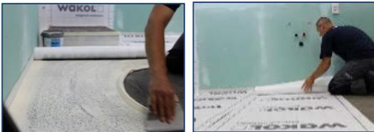
**\*Schritt 6 //** WAKOL MS 552 PVC- und Gummiklebstoff mit Zahnung TKB B1 auf den Boden auftragen und ca. 20 Minuten ablüften lassen, um die Anfangshaftung zu erhöhen.
