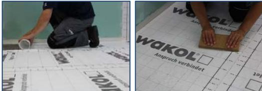
**\*Schritt 7 //** WAKOL MS 552 PVC- und Gummiklebstoff auf den markierten Bereich links und rechts des Bahnenstoßes auftragen und mindestens 20 Minuten ablüften lassen.
